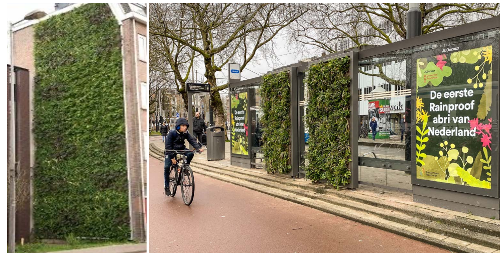
Figuur 19: Voorbeeld groene schermen op bestaande bouwwerken.
